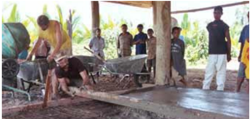
Hier ist der Missionar gerade mit dem Abziehen des Bodens beschäftigt.
